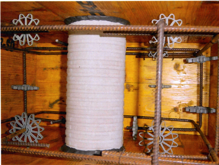
Bild 1: Horizontal ausgerichtete Mauerhülse Futterrohr-Faserzement FU-FZ DN 100 vor dem Betonieren des Prüfkörpers
